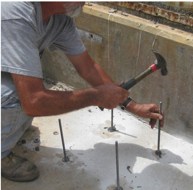
Figure 5: Après avoir rempli le trou avec la résine, les tiges filetées ont été insérées au marteau car le diamètre du trou était trop petit. Le diamètre de perçage nécessaire doit être clairement établi dans les instructions de pose des ancrages chimiques.
