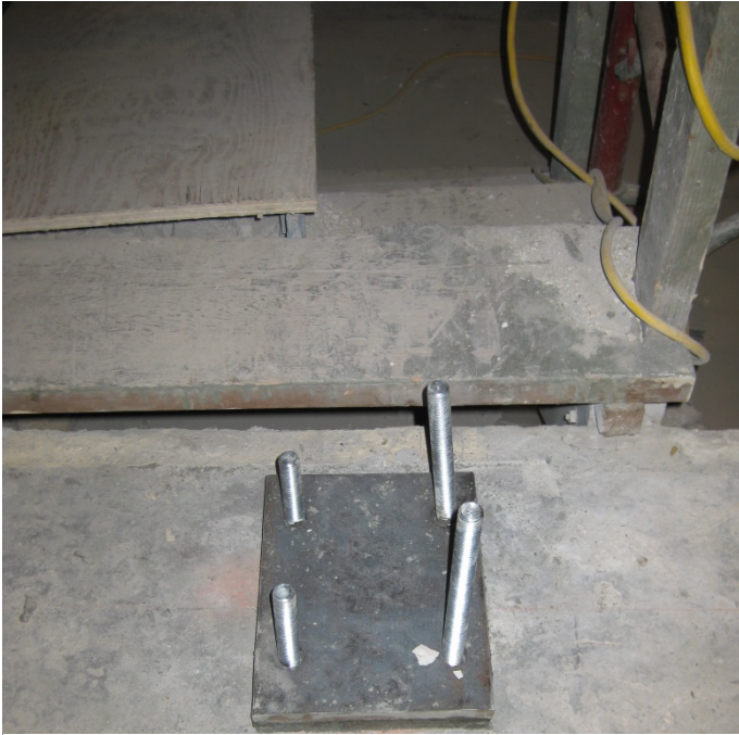
Figure 3: Pour éviter les problèmes d'interférences, les fers doivent être repérés avant de percer et des précautions doivent être prises avec précision pour permettre le réglage des points de fixation. Sinon, les fers pourraient être transpercés, ce qui affecterait la capacité de la structure. Ici, le poseur a tenté d'éviter les barres non détectées par l'inclinaison des forages. Les deux longueurs des tiges filetées montrent l'échec de la tentative.
