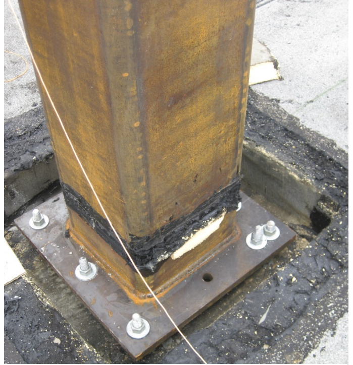
Figure 4: Des limites doivent être fixées quant au positionnement de la cheville. Dans cette application, un deuxième trou (ainsi que sur la platine) a dû être percé parce que la mèche a rencontré un fer à l'emplacement d'origine. La capacité de l'ancrage est par conséquent réduite, car l'entraxe résultant est trop petit.
